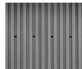
Tertiaire beluchting Ventilation tertiaire
